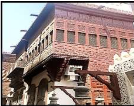
صورة (17) رواشان متصل على جانبي المبنى المصدر: https://www.pinterest.com
